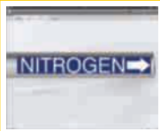
Marcado de tuberías
